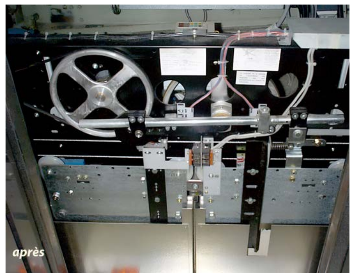
Modernisation de portes de cabine standardisées
