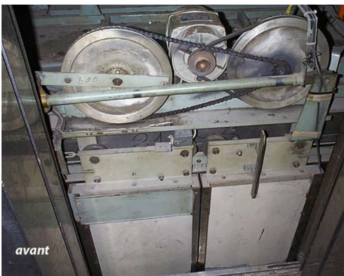
Modernisation de portes de cabine standardisées
